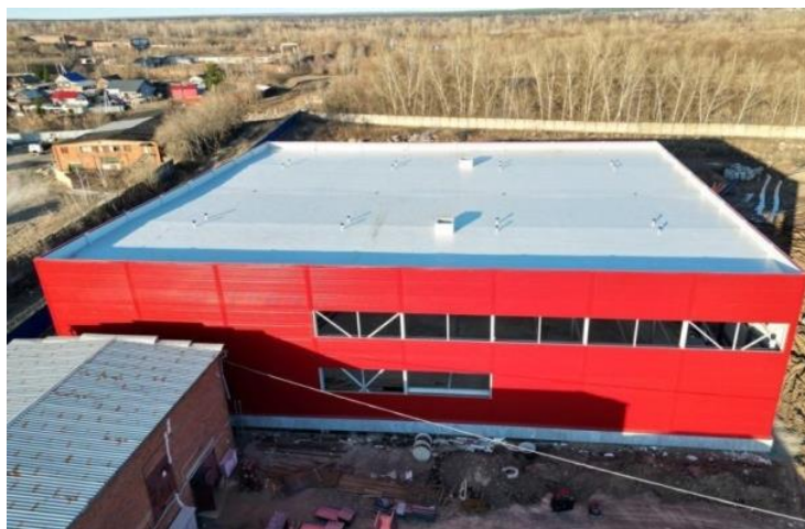
ПРОИЗВОДСТВО ЭЛЕКТРОТЕХНИЧЕСКОЙ ПРОДУКЦИИ
