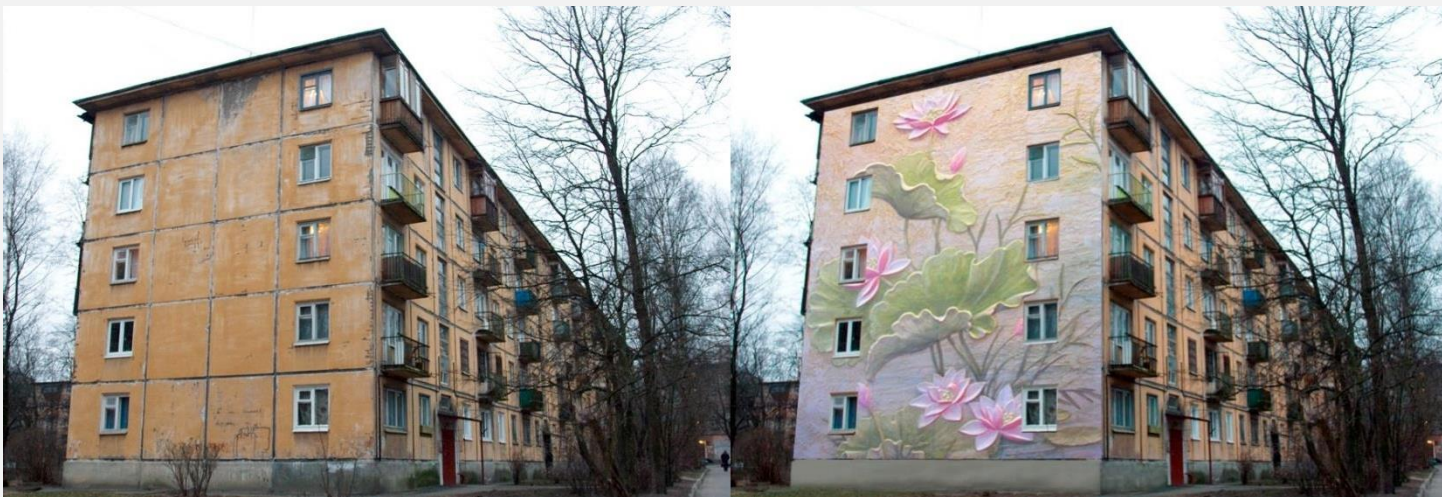
Фасад МКД до утепления термопанелями
